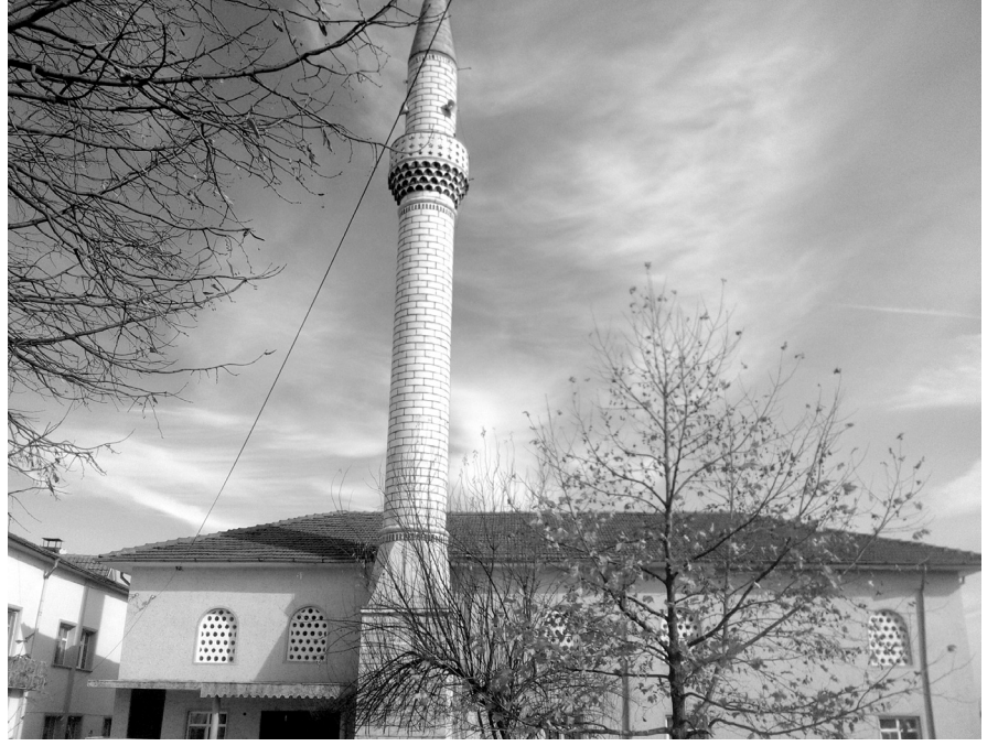
Ferhatlar köyü camii
