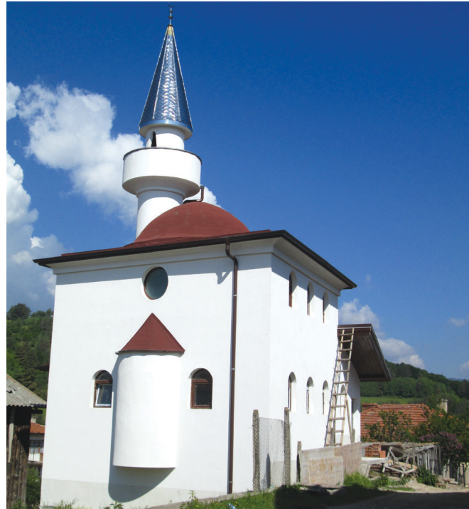
Новопостроена джамия в с. Стоманево, обл. Смолян
