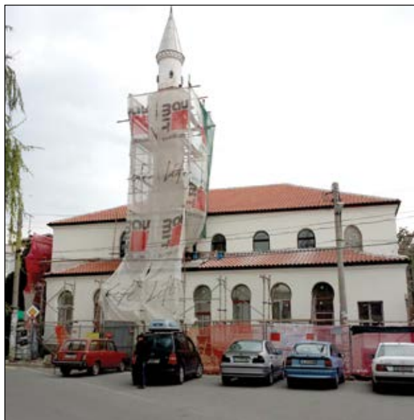
Айтоската джамия в ремонт
